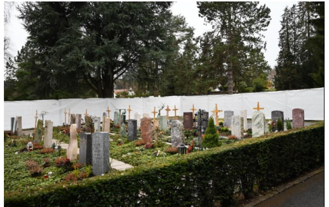
Die Bauarbeiten werden mit weiss eingekleideten Absperrgittern vom Rest des Friedhofs abgeschirmt.
